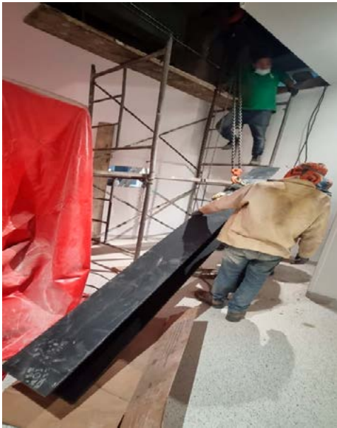
Reforzamiento estructural y Platina soporte base de equipo.
