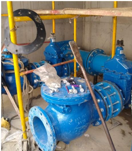
**Montaje de válvulas tanque de bombeo**
